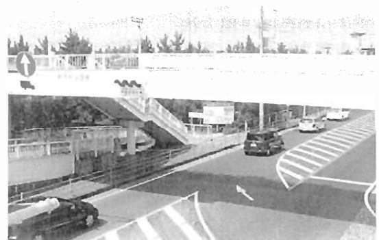
図 10. 設置場所④の設置状況
